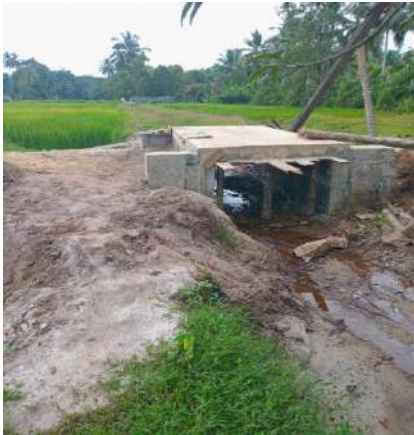
ගෝවින්න කොටා රෝඩ් ප්‍රධාන මාර්ගයෙන් හැරී යන හතරවන අතුරු මාර්ගයේ කැඩීගිය බෝක්කුව සඳහා නව බෝක්කුවක් ඉදිකිරීම
